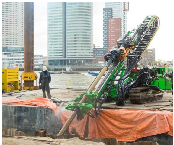
Forage directionnel horizontal (FDH)
