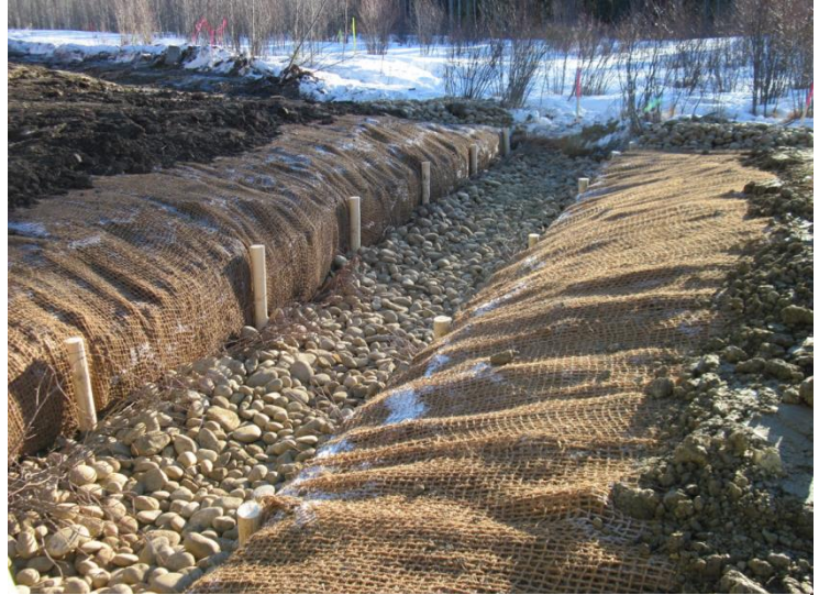
Franchissement avec tranchée isolée
