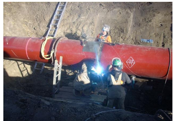
Soudure de raccordement
