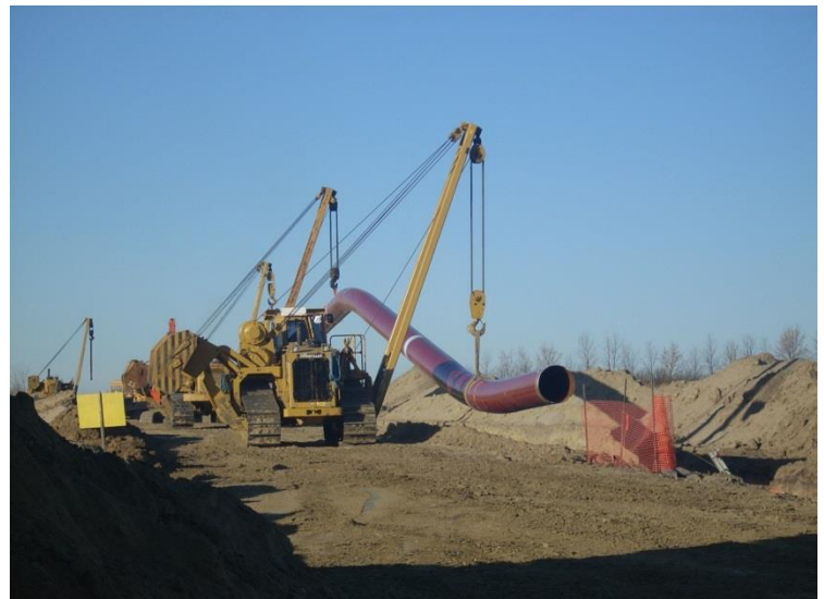
Mise en place dans la tranchée
